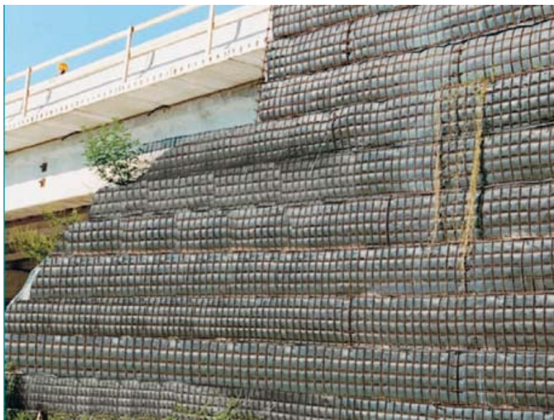
图 2 公路桥头过渡段返包式加筋土挡墙
