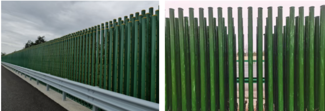
图 15 声子晶体声屏障——江西樟吉高速、江西昌九高速
